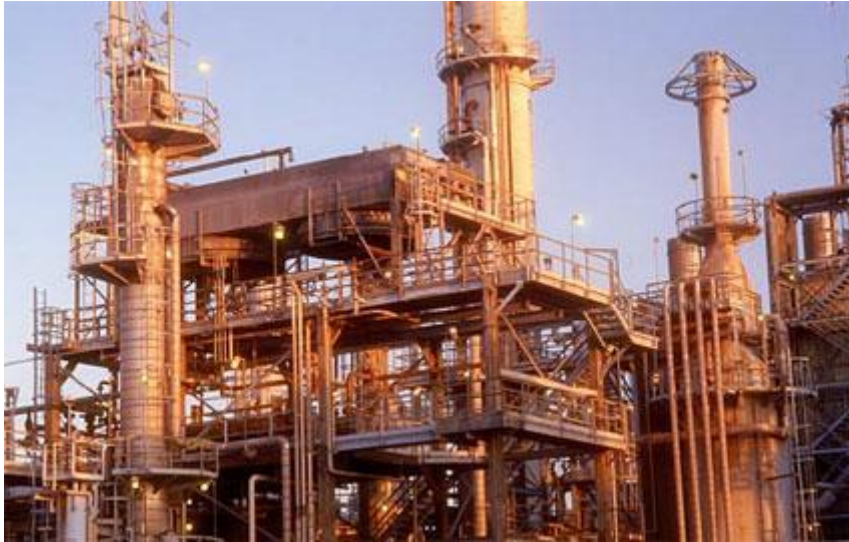
Refineria de petroli
