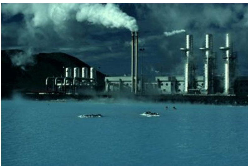
Central geotèrmica en Islàndia
