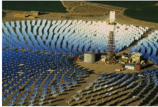
Panels d'energia solar. En la part central, s'observa el col·lector d'energia, cap al que es dirigeixen tots els panells.
